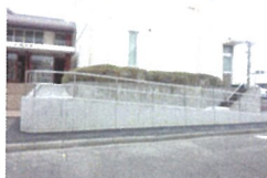
玄関前スロープ
